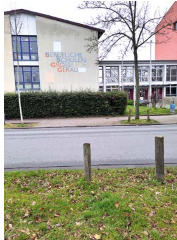
Die Gebäude der Beruflichen Schulen Groß-Gerau sind, wie auf den ersten Blick ersichtlich, deutlich in die Jahre gekommen.
